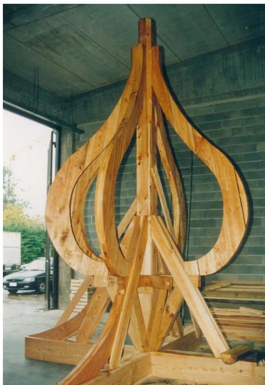
Ricostruzione della nuova cupola, identica a quella esistente, struttura portante ed assito, eseguita nel ns. laboratorio di Appiano (BZ), in legname di larice compresi pezzi speciali, successivi trasporto a piè d'opera, smontaggio in vari elementi e rimontaggio. Nuova copertura in rame con ingraffiature doppie
