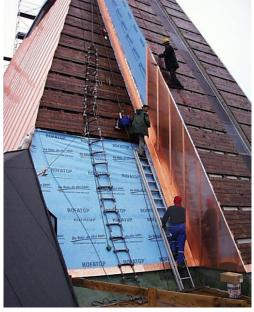
posa in opera delle lastre di Tecu Zinn e lastre di rame, sempre a doppia aggrafiatura
