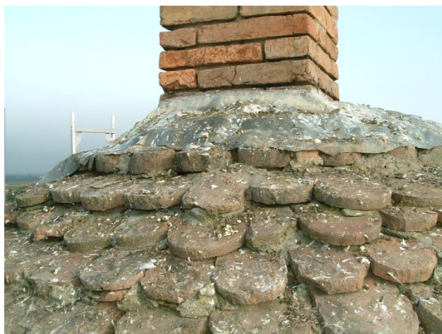
prima del intervento
